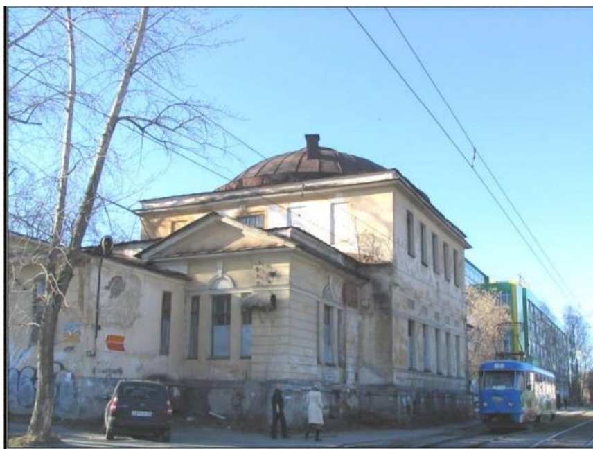
Комплекс бывшего травмпункта Верх-Исетского района, 2010 г.
